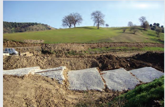
consolidamento della calotta della galleria nel tratto iniziale, dove lo spessore della copertura è scarsa: a sinistra, rappresentazione del risultato in termini di tensione nelle zone consolidate, a destra l'opera realizzata successivamente al calcolo di verifica
