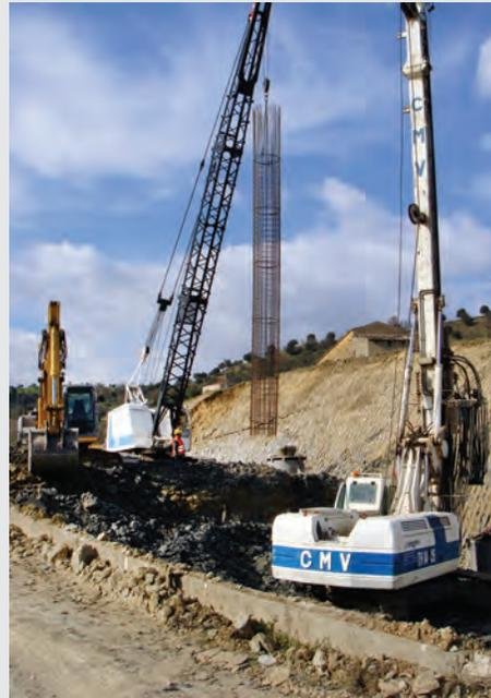
esecuzione di una paratia di pali di 1.200 mm di diametro e della lunghezza di 32 metri, destinata alla stabilizzazione di un pendio in frana
