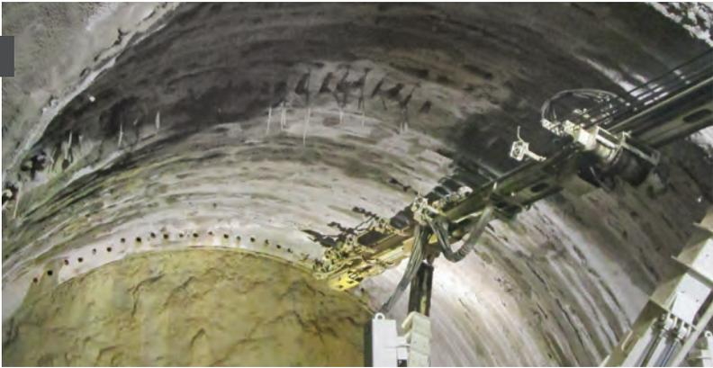
Per ammassi maggiormente fratturati, caratterizzati da parametri geotecnici più scadenti, sono state adottate le sezioni di scavo tipologico 2 e 3, con interventi di presostegno al contorno del cavo e consolidamento del fronte, nonché il successivo scavo a piena sezione con l'utilizzo di martelloni.
