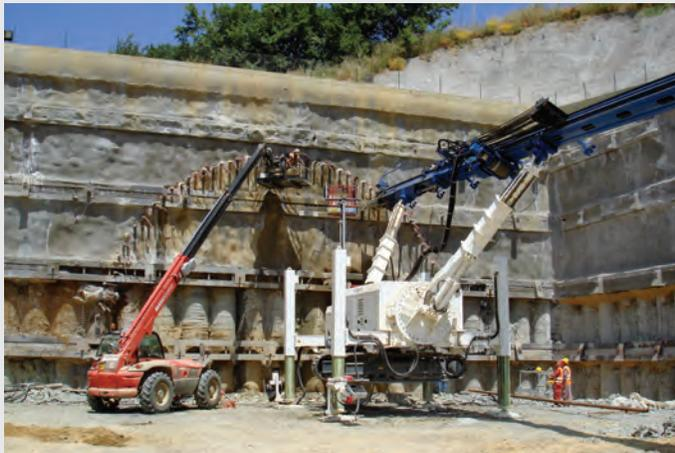
la realizzazione di gallerie è l'attività principale di Idrogeo: nella foto, consolidamento con infilaggi del primo campo di scavo
