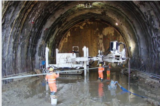
operatori Idrogeo durante il caricamento del posizionatore con tubi in VTR, per il consolidamento del fronte, per l'avanzamento dello scavo
