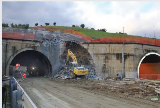
fase di scavo del terreno precedentemente consolidato, nei lavori di allargamento della sezione di una galleria autostradale esistente
