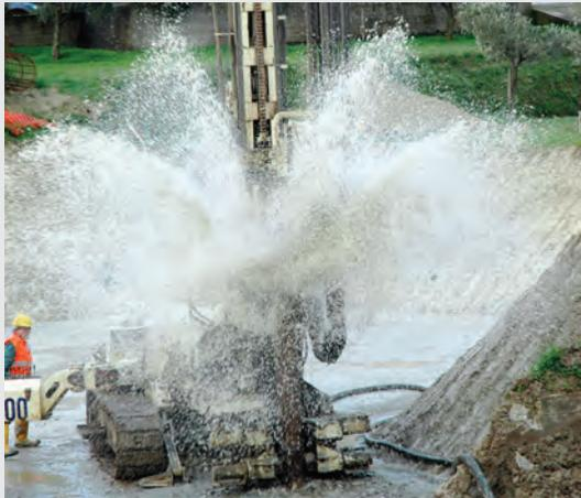
il Jet Grouting è un sistema collaudato per il consolidamento di terreni: nella foto, campo prova per la definizione delle pressioni di iniezione
