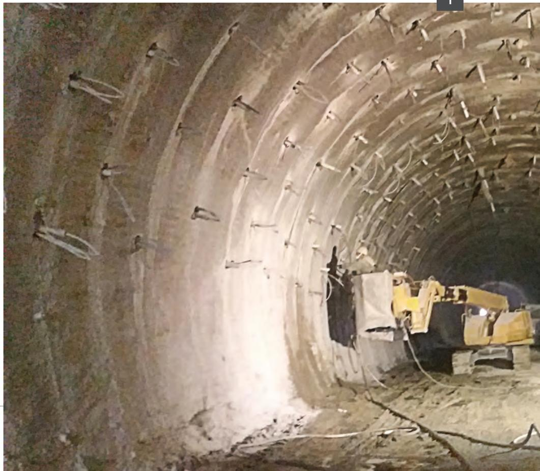
che ha previsto l'intasamento di cavità rilevate a tergo del rivestimento esistente mediante iniezione di malta cementizia alleggerita, il consolidamento radiale attraverso elementi di rinforzo in VTR tipo P.E.R. Ground, nonché il successivo scavo di avanzamento e demolizione della galleria esistente con l'uso di martellone.
