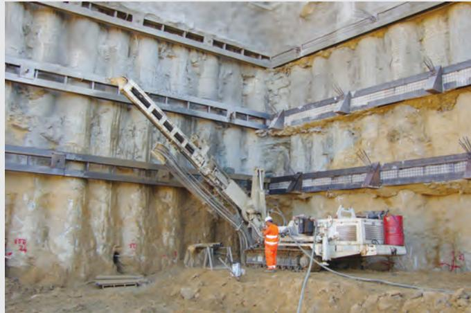
analisi numerica tridimensionale agli elementi finiti di verifica preliminare alla costruzione (foto a destra) di una paratia di pali di grande diametro con quattro ordini di tiranti; altezza fuori terra dell'opera pari a circa 16 metri
