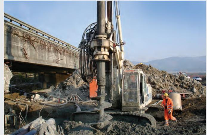
esecuzione di pali di 1.200 mm di diametro e 26 metri di profondità, con l'uso di elica; i pali costituiranno la futura fondazione di una pila da ponte
