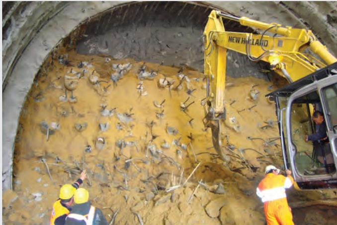
primo piano del terreno interessato dallo scavo, caratterizzato da scadenti parametri geomeccanici: in evidenza, il necessario, preventivo consolidamento dello stesso con un elevato numero di iniezioni
