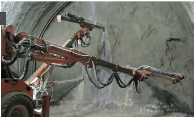
[4] *Perforazione con Jumbo per inserimento di mine nei fori (scavo con esplosivo)*
