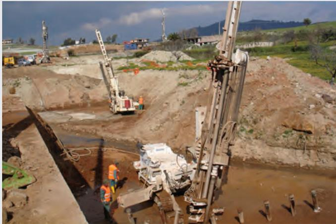
esecuzione di batterie di micropali di 300 mm di diametro, per la realizzazione di fondazioni indirette di pile da ponte
