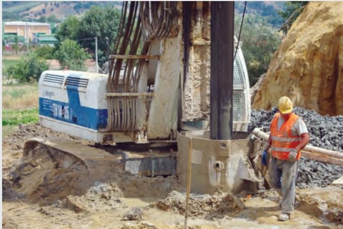
esecuzione di pali di 1.500 mm di diametro e 32 metri di profondità, con l'uso di rivestimento vibro-infilato; i pali costituiranno la futura fondazione di una spalla da ponte autostradale
